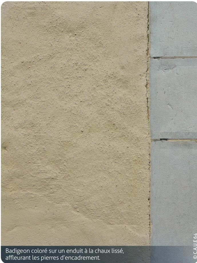
Badigeon coloré sur un enduit à la chaux lissé, affleurant les pierres d'encadrement.
