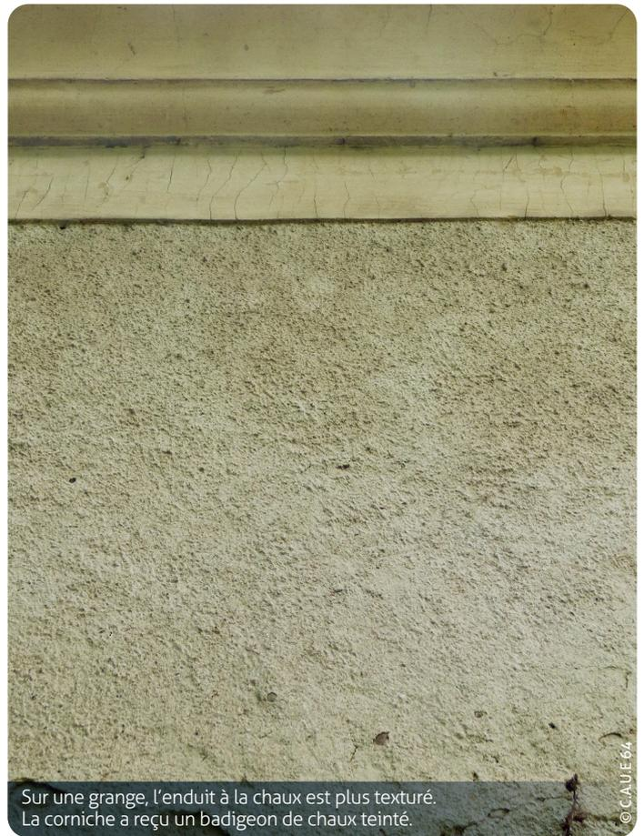
Sur une grange, l'enduit à la chaux est plus texturé. La corniche a reçu un badigeon de chaux teinté.
