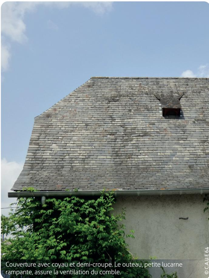
Couverture avec coyau et demi-croupe. Le outeau, petite lucarne rampante, assure la ventilation du comble.
